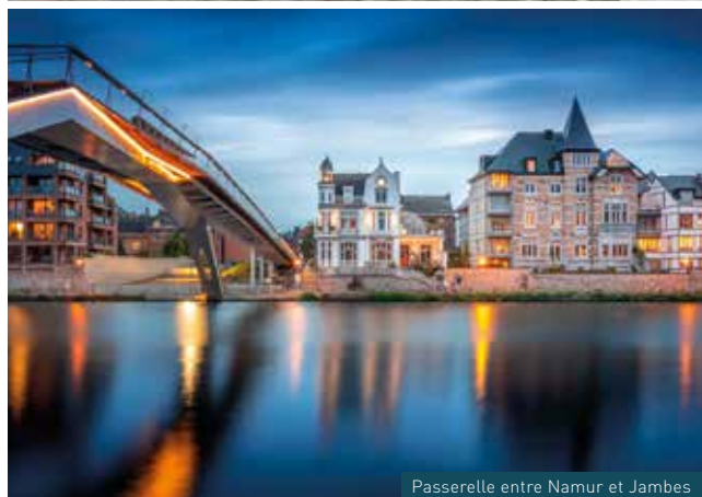
Passerelle entre Namur et Jambes
